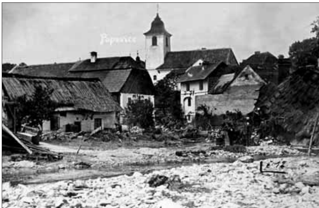
Popovice – poškozený domek Josefa Krosnáře čp. 15 a poškozený domek o odplavená stodola patřící Antonínu Zemanovi z čp. 12 (foto: Kronika fary Popovice).
