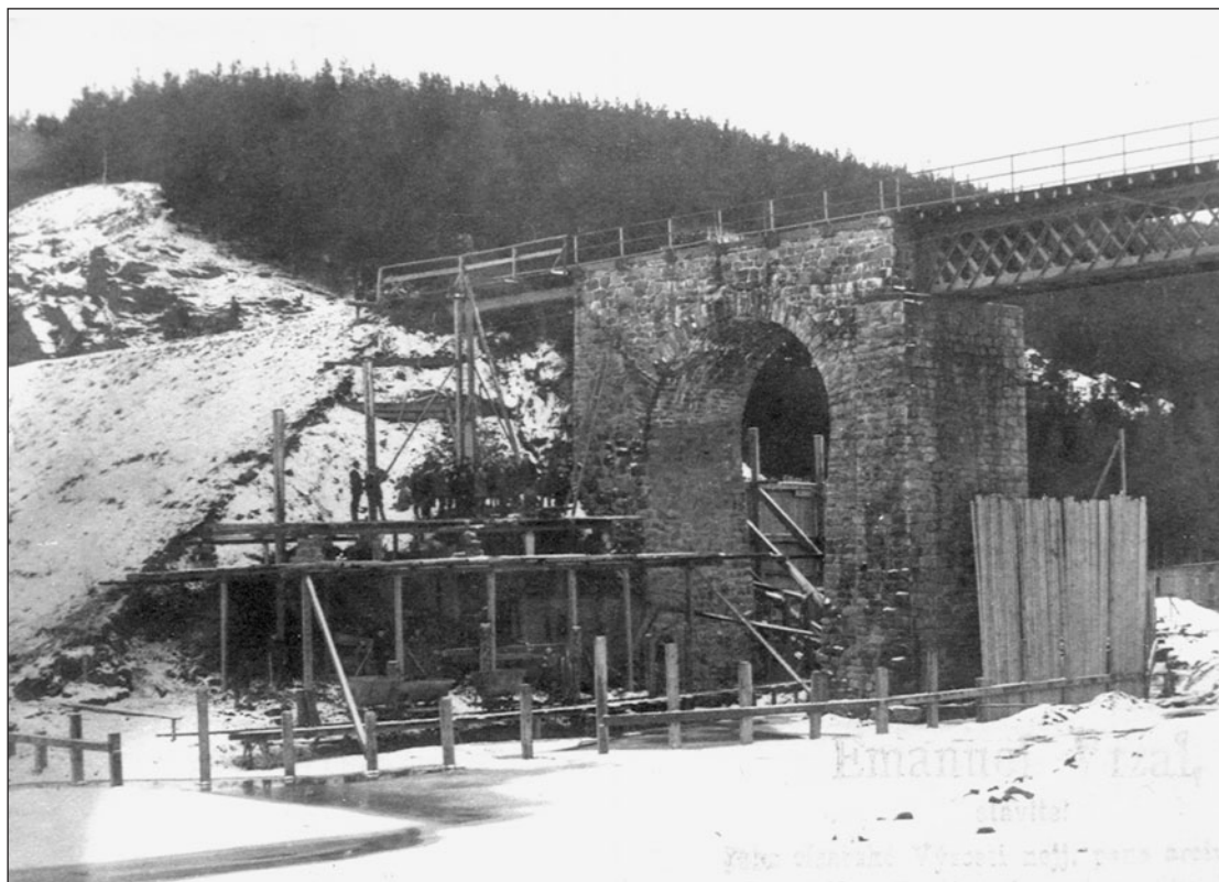
Městečko – oprava železničního mostu ve Lhotce po povodni (foto: sbírka Františka Kavky).
